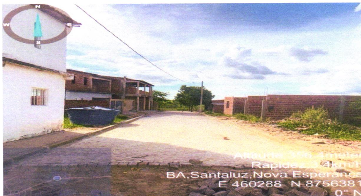
Execução de pavimentação Rua 04 Deloda
